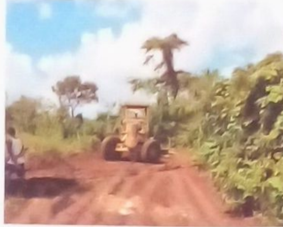
Construcción de los caminos internos de Sabana de los Javieles.
